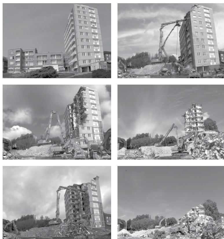
Cité Grand Pré, demolition in 2023.
